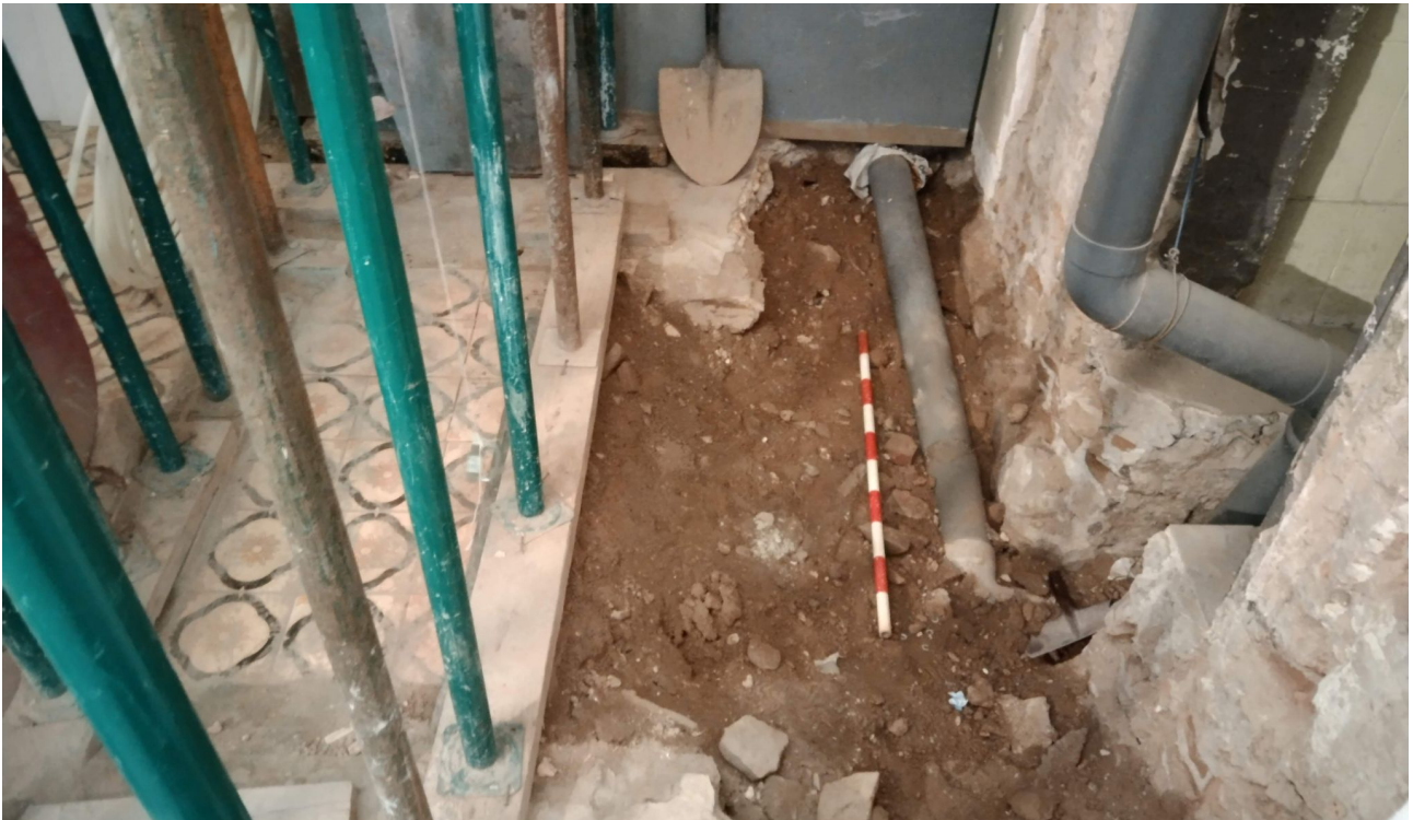
1. Vista inicial de la cala, una vegada retirat el paviment UE 101 i la preparació de morter UE 102, deixant a la vista el rebliment UE 103.
